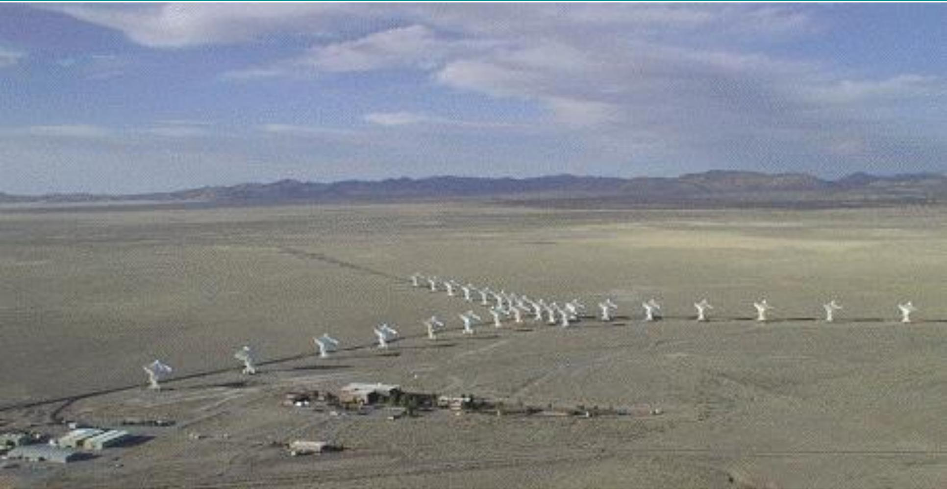
Il VLA americano nel deserto di Socorro (Nuovo Messico), è il più grande radiotelescopio al mondo. È composto da 3 bracci a forma di Y, ciascuno lungo 35 Km, con 9 antenne a parabolide ciascuna del diametro di 25 metri (operanti nell'intervallo di frequenze da 1 a 24 GHz).
