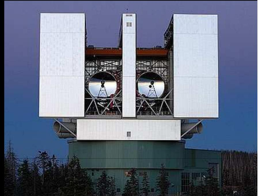
LBT è costituito da due specchi parabolici primari composti da un unico blocco di vetro ricoperto da un sottile strato di alluminio.
