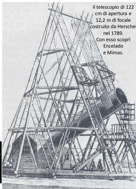
Il telescopio di 122 cm di apertura e 12,2 m di focale costruito da Herschel nel 1789. Con esso scopri Encelado e Mimas.
