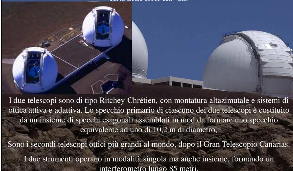
I due telescopi sono di tipo Ritchey-Chrétien, con montatura altazimutale e sistemi di ottica attiva e adattiva. Lo specchio primario di ciascuno dei due telescopi è costituito da un insieme di specchi esagonali assemblati in modo da formare uno specchio equivalente ad uno di 10,2 m di diametro.
